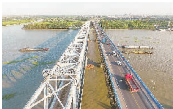
改造前的松浦大桥
