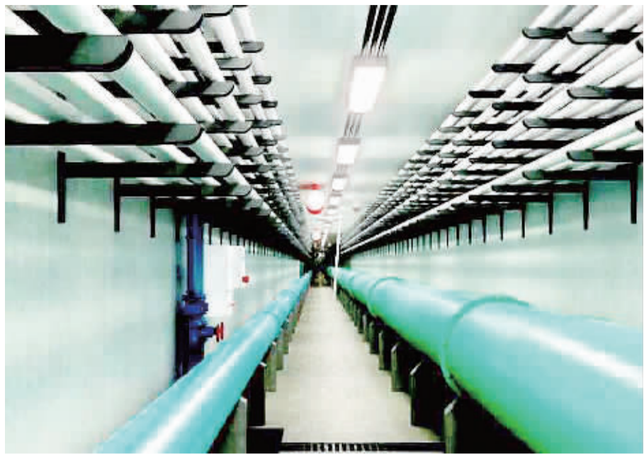
图为上海市政总院承建的地下综合管廊工程实景图
