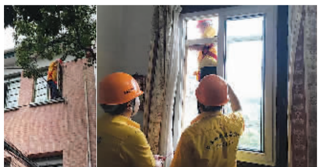
居民家中晾衣架被风吹断，在风中剧烈摇晃。长宁区应急维修中心的维修人员爬上窗台抢修。
