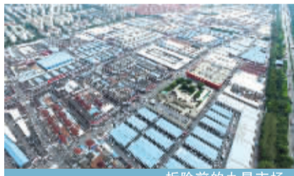
拆除前的九星市场
